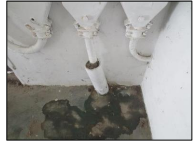
Photo N° 1148 AMIANTE CIMENT -- DEGAGEMENT -1 Gaines & coffres verticaux Fourreau
