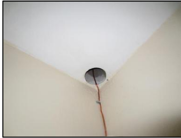
Photo N° 1145 AMIANTE CIMENT -- PALIERS RDC à +4 Plafonds Fourreau
